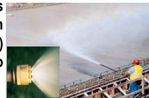
Rociar la losa y piso inmediatamente después de la colocación (mínimo por 7 días) para evitar la deshidratación del concreto premezclado.
