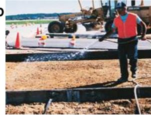
Compactar perfectamente y humedecer toda la superficie para evitar que el concreto premezclado pierda su humedad.
